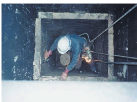
レンガ撤去中
