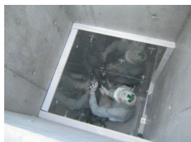
ライニング材直貼り
